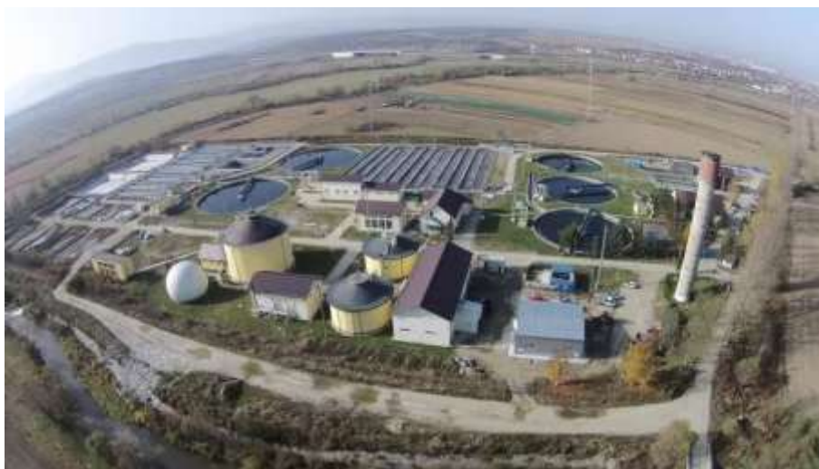
Stația de epurare Mohu, Sibiu. Sursa foto: www.oradesibiu.ro
